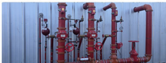
Estación de control con válvulas e indicadores.
